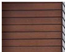
Deski elewacyjne włóknocementowe imitujące drewno.
