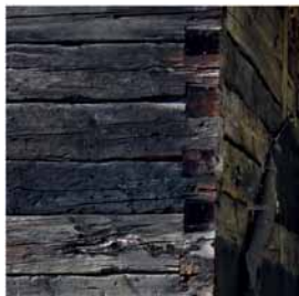
Złącze ścian wieńcowych w narożach – nakładka obustronna.
