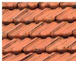
Dachówka typu marsylka, kolor: naturalna czerwień.
