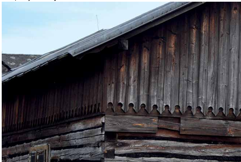
Detal, budynek z miejscowości Płaza.
