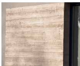
Okładzina z paneli elewacyjnych imitujących drewno.
