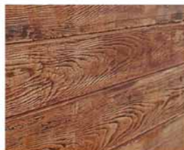
Tynk strukturalny elewacyjny imitujący drewno.
