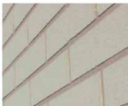
Tynk strukturalny elewacyjny imitujący kamień.
